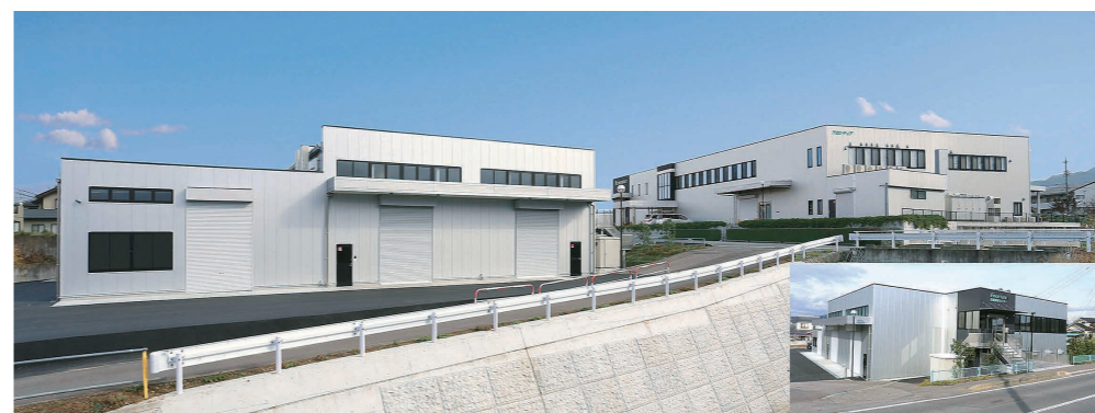
ヤマウラが建設に携った本社屋と技術開発センター
